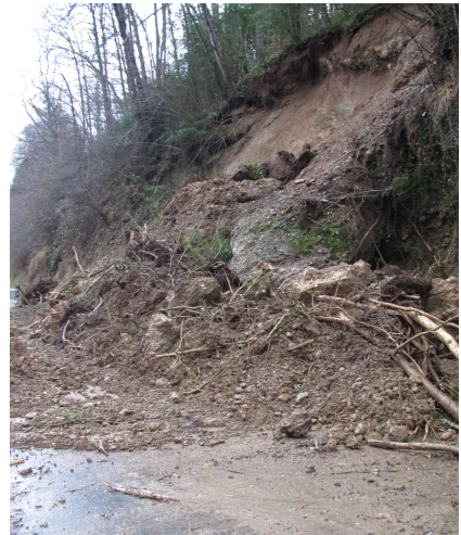
Les glissements de talus sont fréquemment observés après de fortes intempéries (photo non-représentative du territoire)
